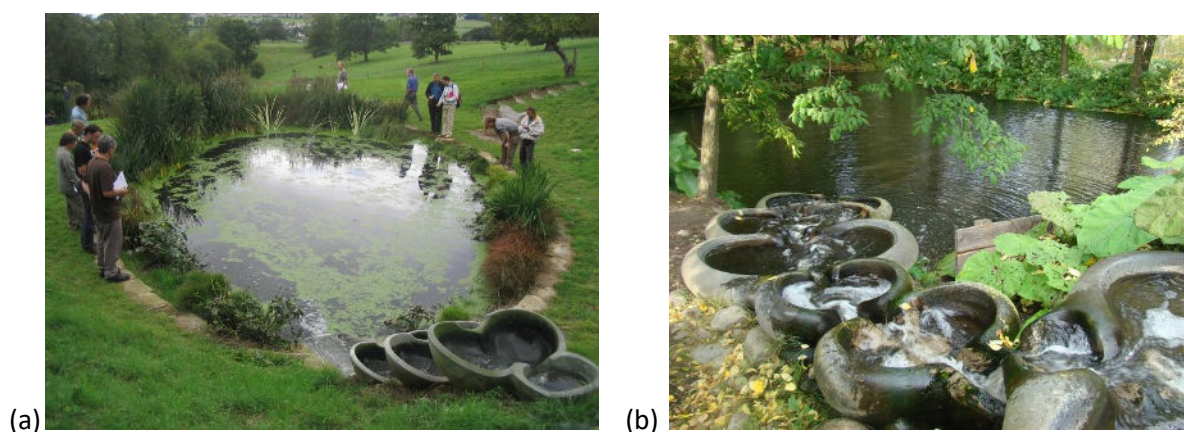
Figure 13 : de gauche à droite (a) Brassage sur lagunes d'eaux chargées en azote et phosphore (effluents domestiques: lavages, toilettes etc..) avec le modèle «Odysée» et (b) «Aquila» ; Crédit photo Aïga Terra
