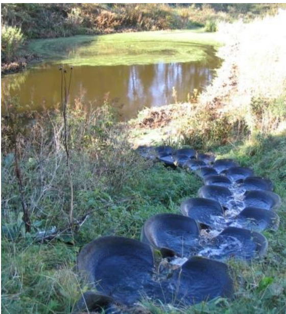
16 Brassage sur lagune d'eaux chargées
