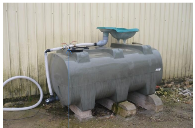
21 Eau stockée sur cuve de rétention 3000 l Brassage de vitalité: 15 mn /jour, de préférence le matin Brassage des substances ajoutées : 90 mn (ou 3 Vasques 30 mn) Pompe en bout de cuve. Vannes de dérivation vers pulvérisateur *
